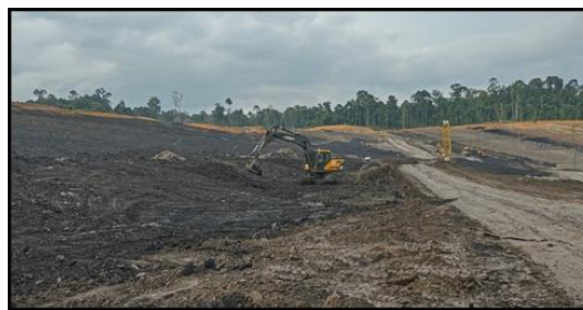
Gambar 5. Aktivitas Penanganan Material Batubara pada Area Tambang.
