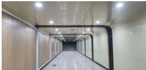
Gambar 1. Box Culvert sebagai Underpass Tunnel di Bundaran Besar, Kota Palangka Raya, Provinsi Kalimantan Tengah.
