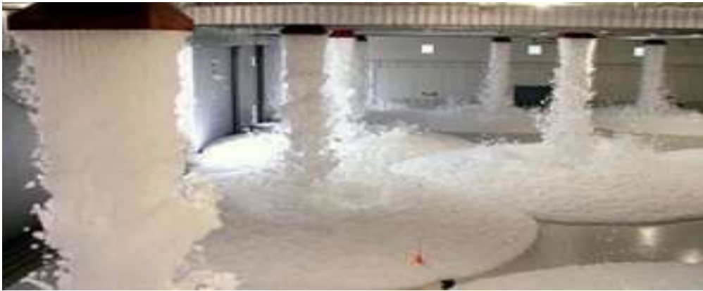
Gambar 6: Busa udara bertekanan adalah sistem pemadam api yang efektif, terutama di industri kimia dan perminyakan.
