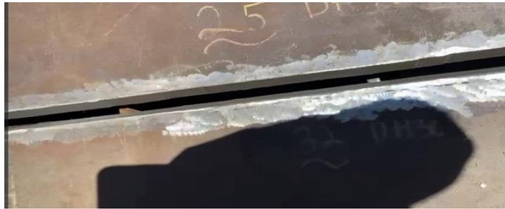
Gambar 10. Area seam join setelah dilakukan pemotongan dan re-bevel
