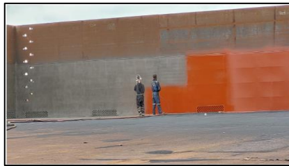
Gambar 3. Pekerjaan Sandblasting pada Sideboard
