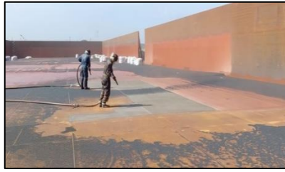
Gambar 2. Pekerjaan Sandblasting pada Maindeck
