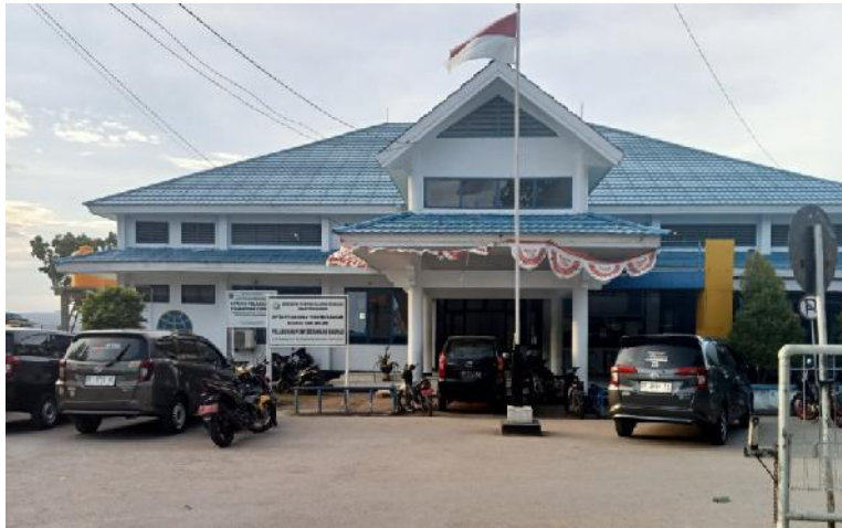
Gambar 1 Pelabuhan Penyeberangan Baubau
