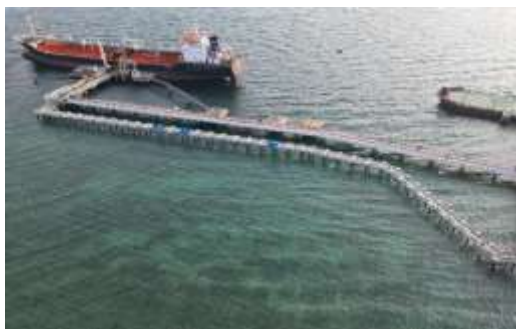
Gambar 2. Jetty 2 PT. Pertamina Port Panjang
