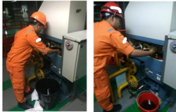
Gambar 4. Pengurasan Oli Pada Drip tray.
