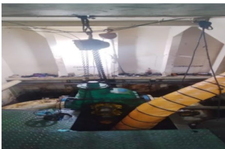
Gambar 3. Pembongkaran Cargo Pump 1
