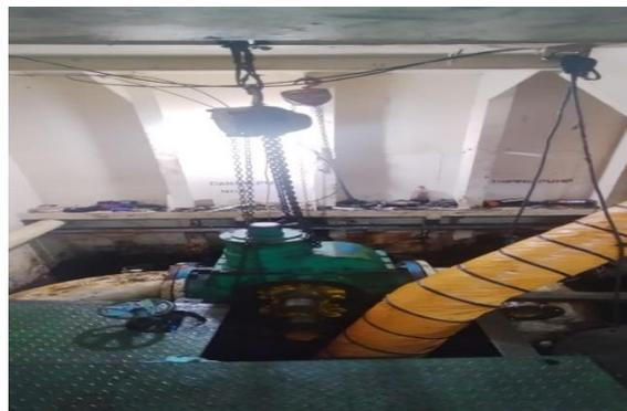
**Gambar 3.** Pembongkaran Cargo Pump 1
