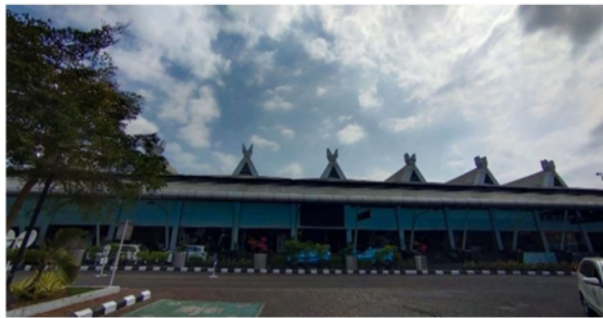
1 Gambar 1. Bandar Udara Husein Sastranegara Bandung
