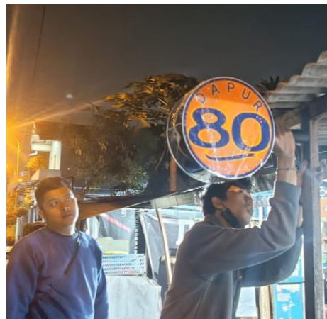
Gambar 9. Pemasangan Neon Box
